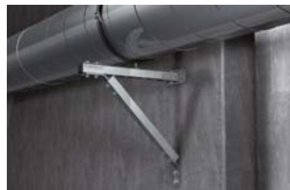
Крепление спирального воздуховода с помощью консоли
