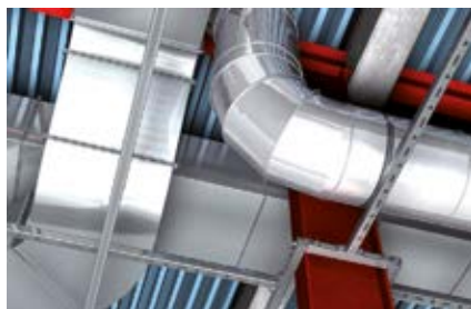
Опорная конструкция для крепления вентиляции
