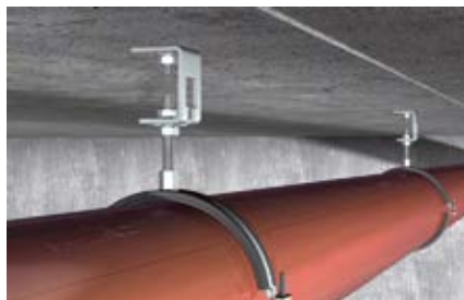
Монтаж трубопровода с регулировкой по высоте
