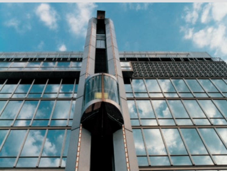
Foto: ThyssenKrupp Aufzüge – Galeria Horten Heidelberg
