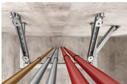
Усиление рамной конструкции с помощью монтажных шин
