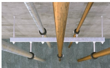
Abgehängte Montageschienen
