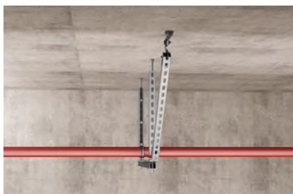
Усиление узла крепления трубопровода с помощью монтажных шин
