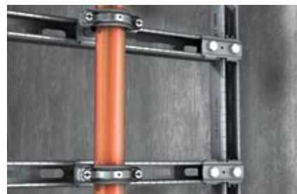
Монтаж трубопровода на вертикальных участках
