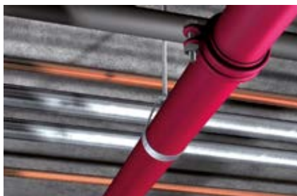
Монтаж спринклерного трубопровода
