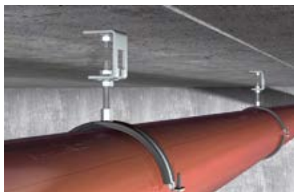
Монтаж трубопровода с регулировкой по высоте
